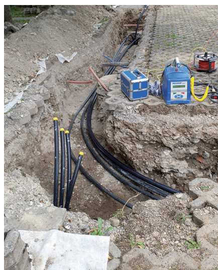
Verbindungsleitungen von der Erdsonde zum Verteiler. Fotos zVg Tschui AG
